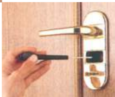
Com uma chave de fendas, desapertar os dois parafusos que fixam o segredo
