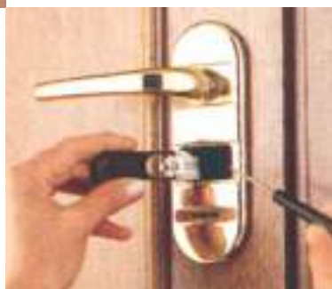
Inserir o novo segredo e aparafusar os dois parafusos de fixação
